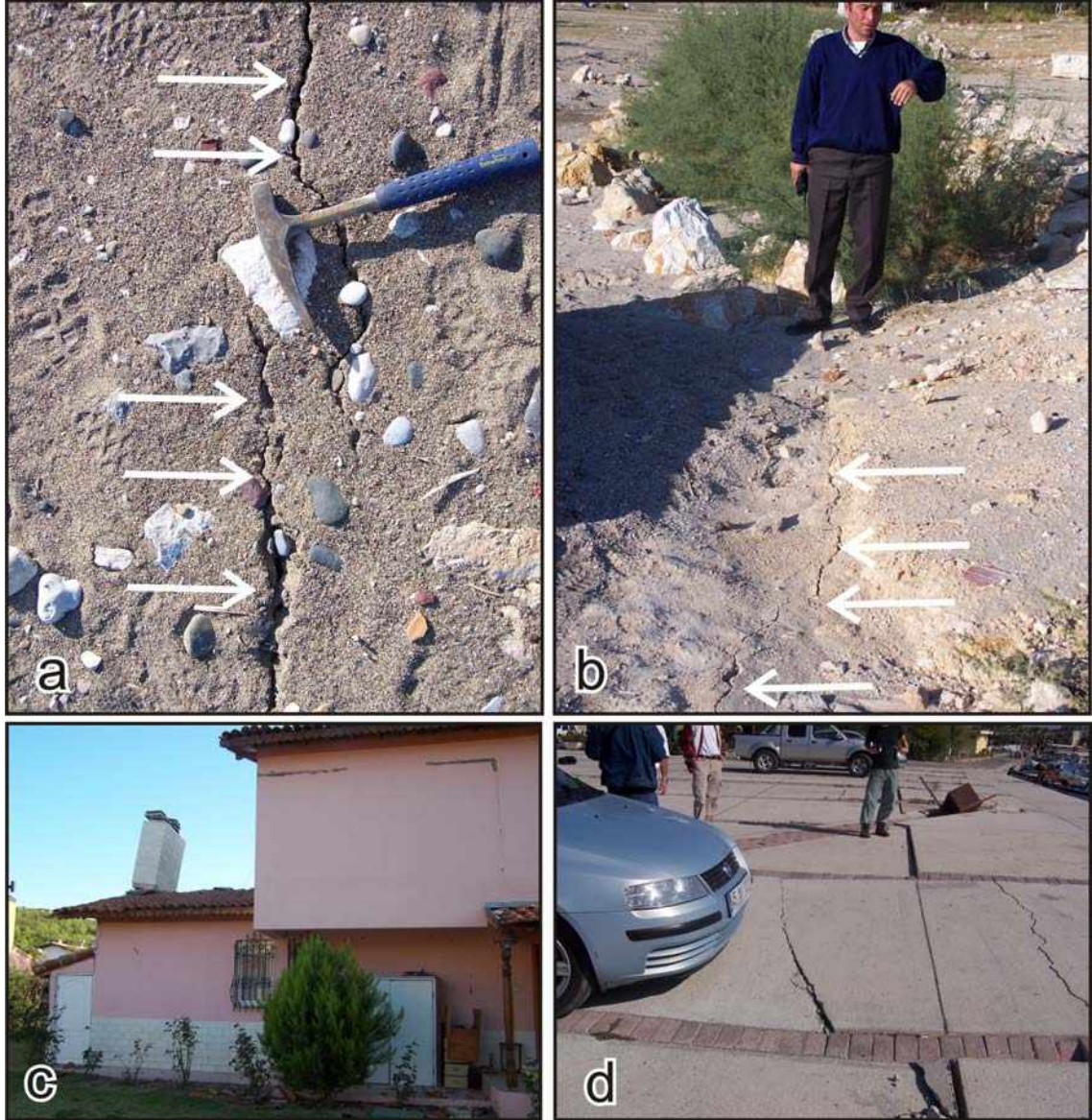
Şekil 7. Sığacık depremlerinin şiddet ölçüsünü belgeleyen hasarlar: a) ve b) Yumlu Çiftliği'nde saptanan ve denizden karaya doğru 500 metre izlenebilen K20D ve K-G doğrultulu kılcal bir yüzey çatlağına ait görüntüler, c) Bu kırık üzerine inşa edilmiş sitelerdeki evlerin makaslanmış duvarları ve devrilmiş bacaları, d) Sığacık limanındaki zeminde oluşan çökme ve yükselmeler.
